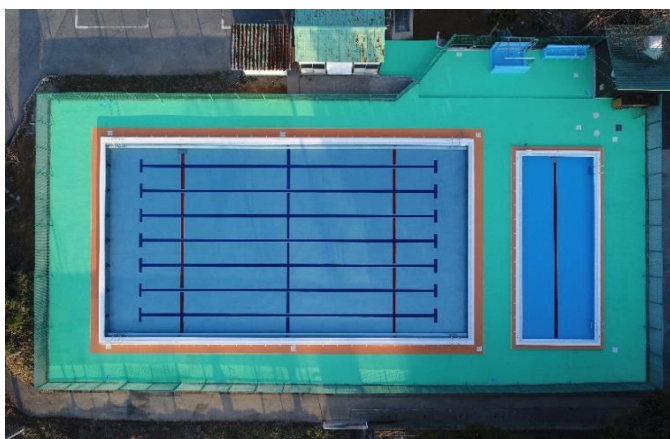
天童市立高揃小学校プール改修工事 H29.10.6～H30.3.23
