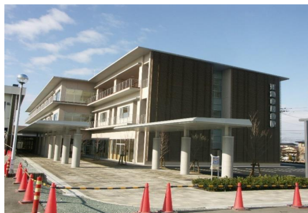
天童市立天童病院新築機械設備工事 H18.8～H19.12
