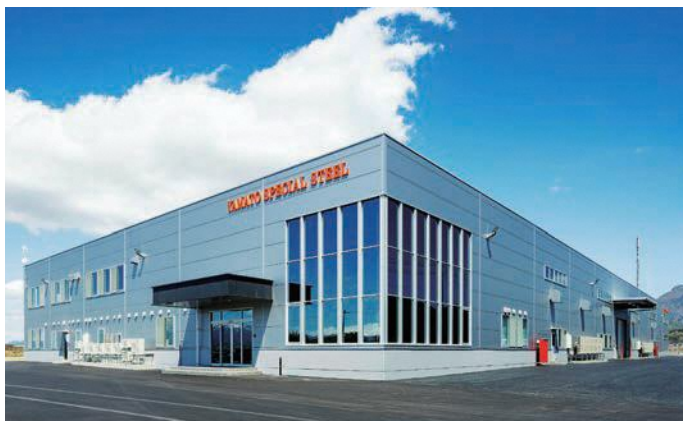
山形第三工場外観
