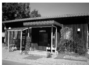
▲老朽化が進む 天童北部学童保育所
