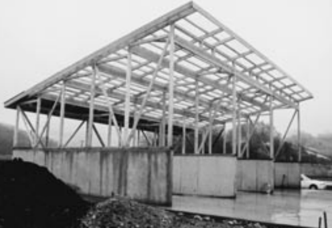
家畜排せつ物法により堆肥舎を整備（二子沢地区）
