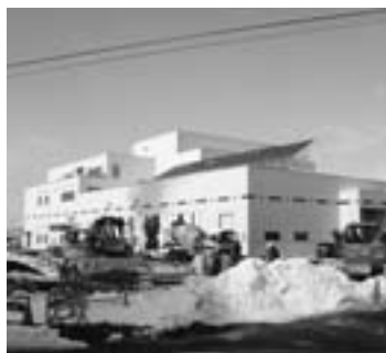
4月稼働に向け工事中のリサイクルセンター
