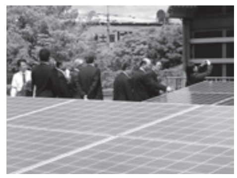
▲太陽光発電システム設置状況を視察（倉敷市）
