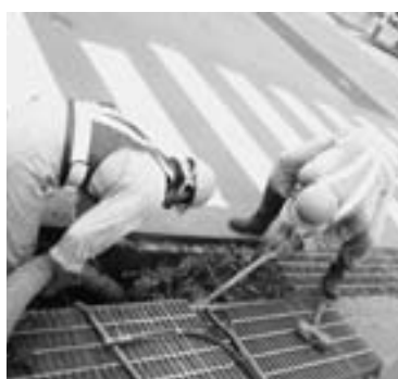
▲側溝の高圧洗浄
