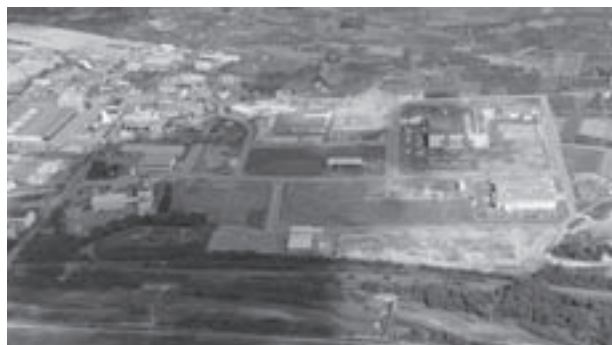
▲企業立地が進む荒谷西工業団地
