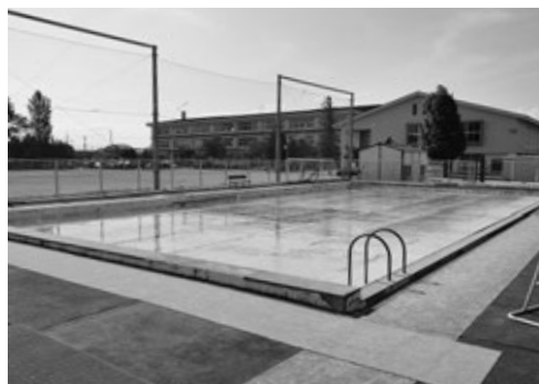
▲改修工事がはじまる蔵増小プール
