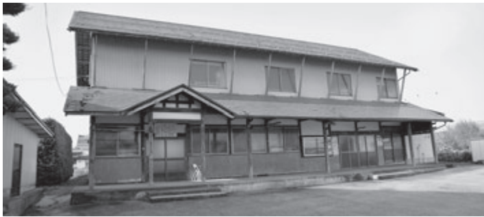
▲解体前の蔵増北公民館
