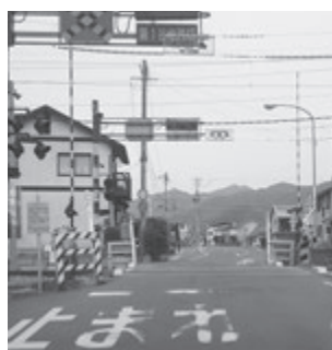
▲幅4.5mしかない第一谷踏切
