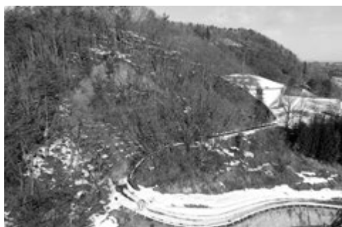
▲法面が崩落した八幡山
