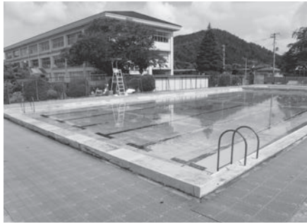
▲改修が予定されている千布小学校プール
