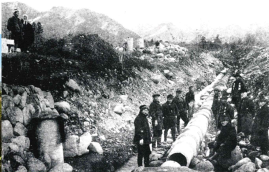
▲水源地送水管埋設工事 写真正面奥の山は、山寺。荒谷水源地から水を引く管を埋設している。
