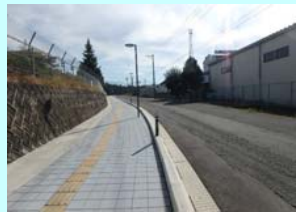
高質空間形成施設 スタジアムまでの歩道改築
