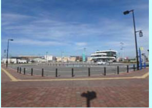
地域生活基盤施設 広場整備
